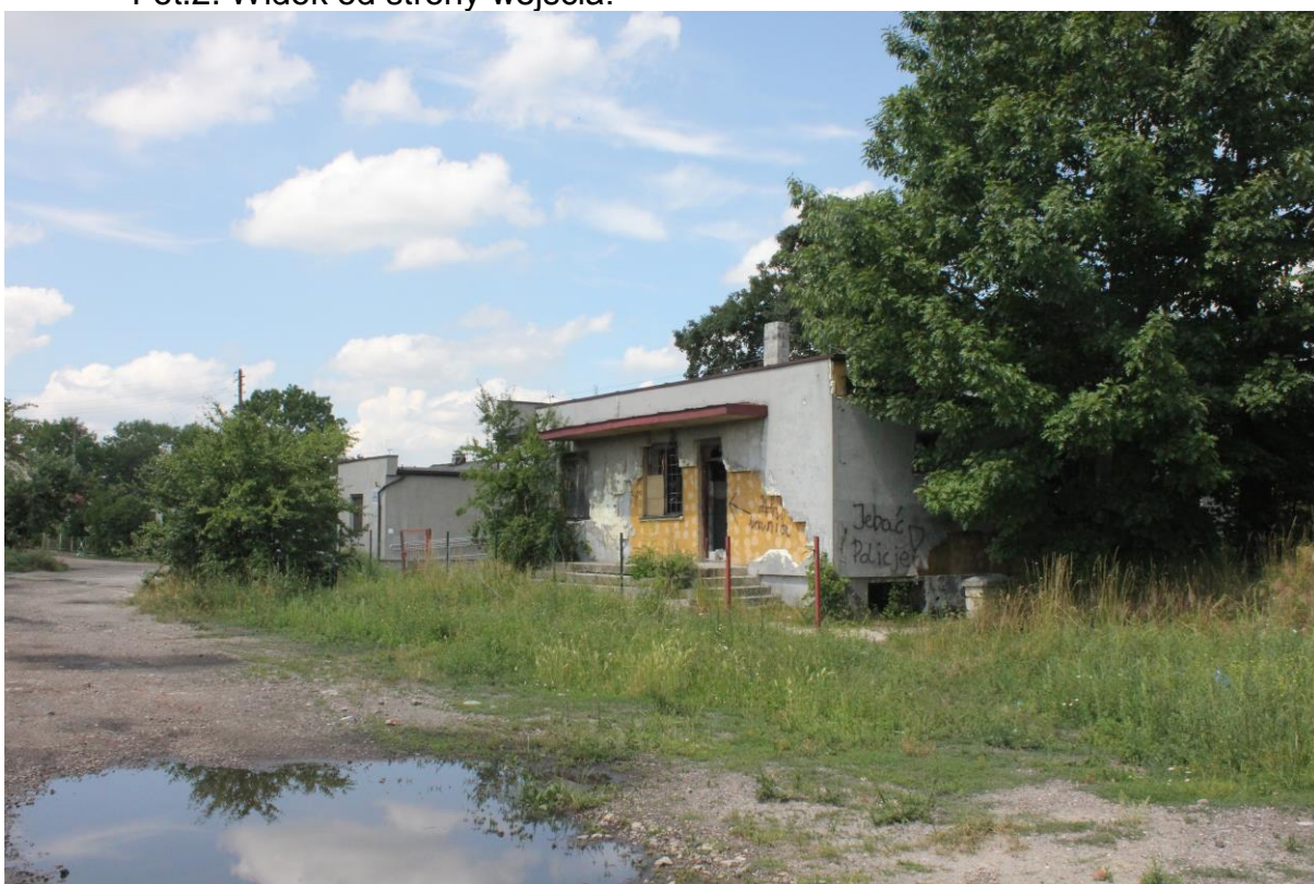
Fot.3. Widok od strony wschodniej
